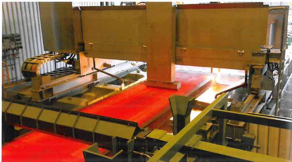
Die neue Stranggießanlage 4 der Salzgitter Flachstahl GmbH
