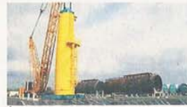
Das sind die Transition Pieces, die von Ambau in Bremen gebaut und in Cuxhaven endausgerüstet und konserviert werden.
