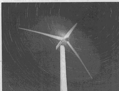
Windräder sollen nach der Energiewende einen Großteil des Stroms liefern
