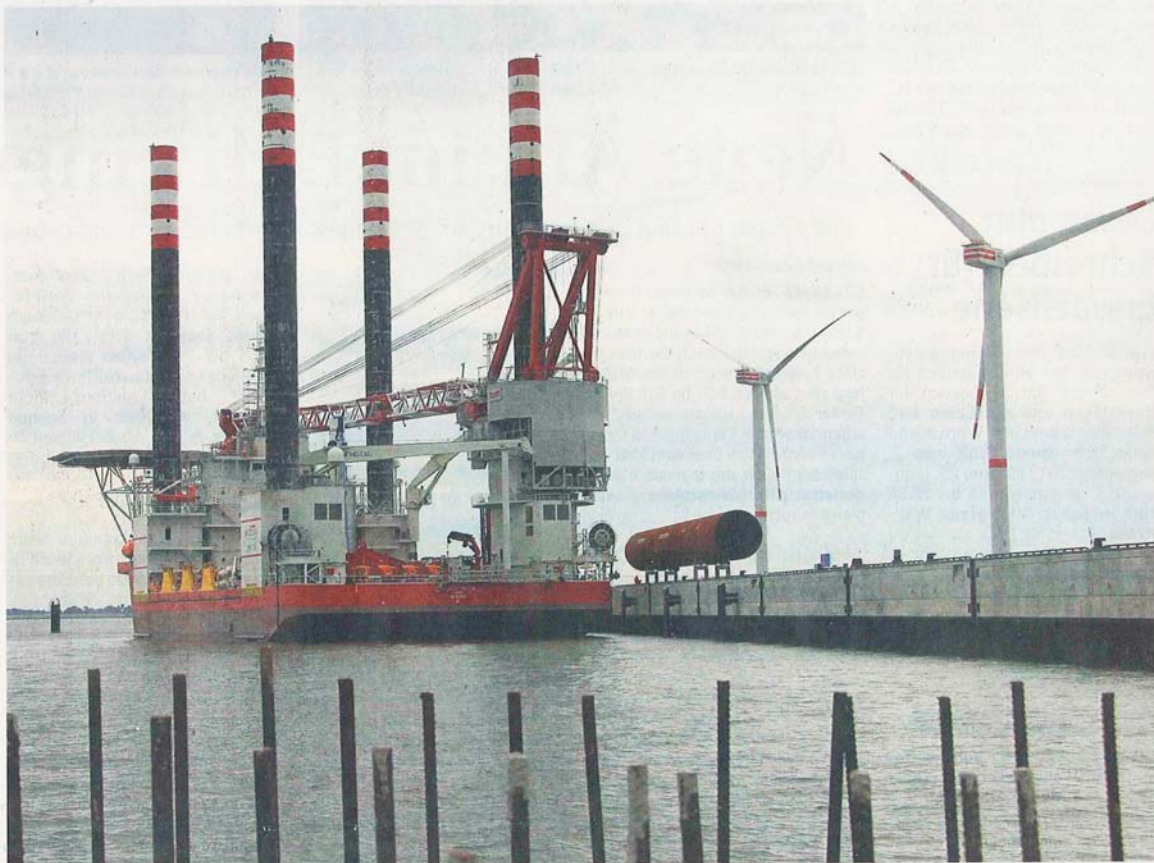
Während im westlichen Abschnitt des Liegeplatzes 9 noch gebaut wird, machte das Errichterschiff „Seajacks Farazan“ Dienstag als erstes Schiff am bereits fertigen östlichen Teil des neuen Offshore-Terminals fest. Es lädt hier künftig die Gründungsrohre für den Windpark, die Ambau fertigt. Foto: Sassen
