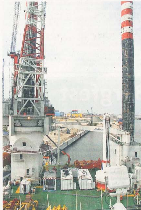
Mit imposantem Gerät arbeiten die Offshore-Spezialisten auf dem britischen Errichterschiff „Seajacks Zaratan“, das nun regelmäßig Cuxhaven anläuft.
